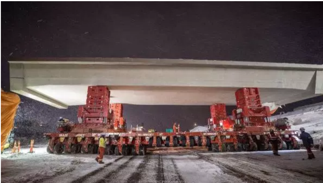
2 – FOTO – Mammoet instalando un puente
