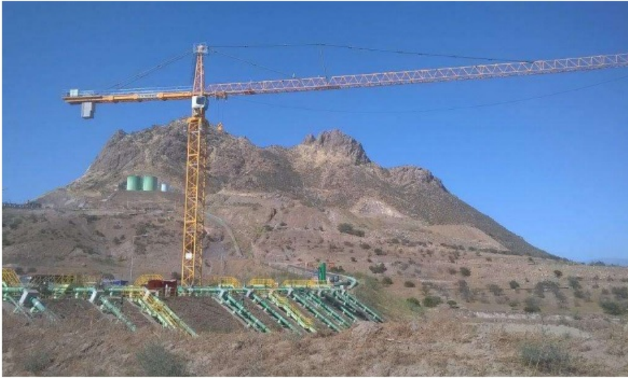
7 Aplicación grúa torre en la Minería
